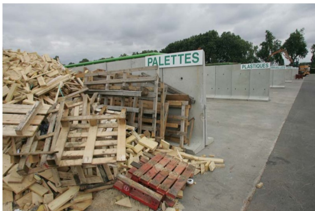
Cases de stockage délimitées par des cloisons préfabriquées en béton armé
