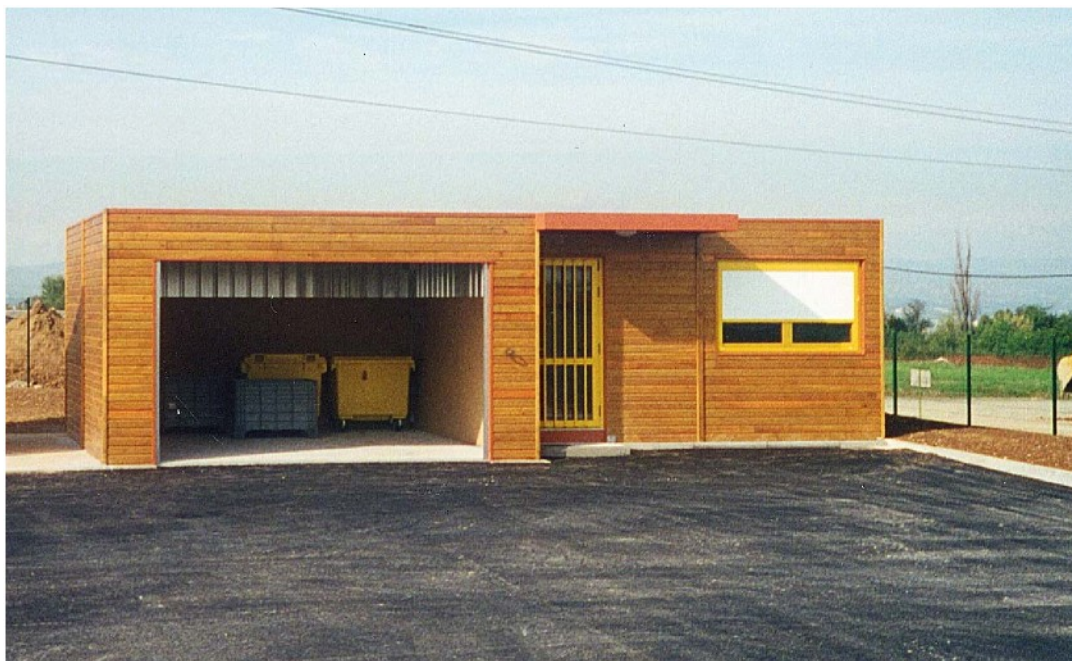
Modules de bureaux et d'abri pour D.I.D. et D.E.E.E. avec habillage des façades en bois
